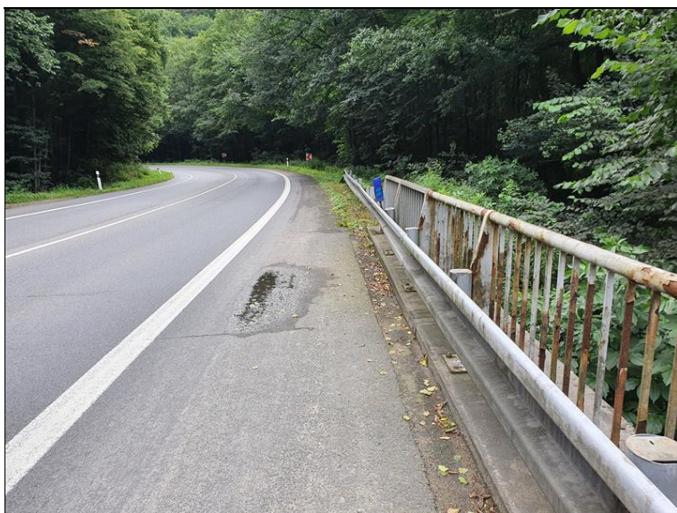
Pravá římsa, stojící voda na vozovce
