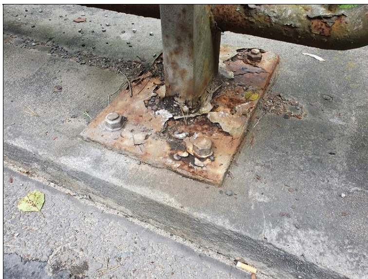
Poškozená patní deska sloupku svodidla
