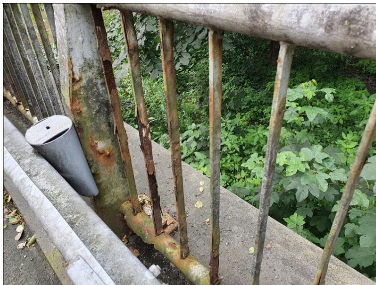
Poškozené svodidlo
