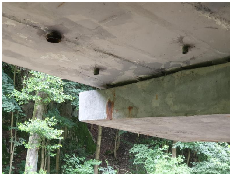
Poruchy na úl.prahu pilíře
