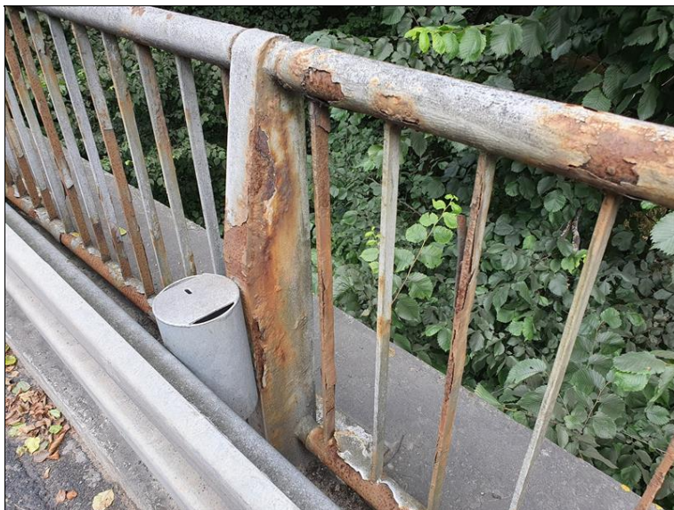
Koroze svodidla
