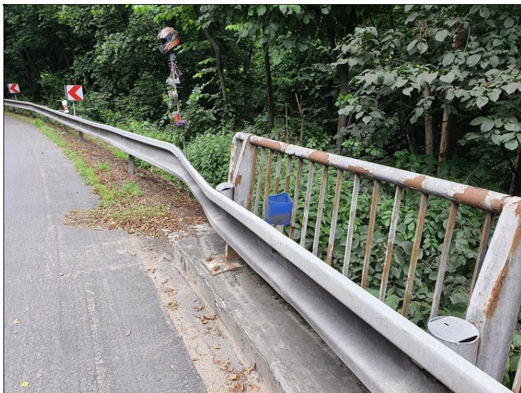
Deformace svodidla za mostem
