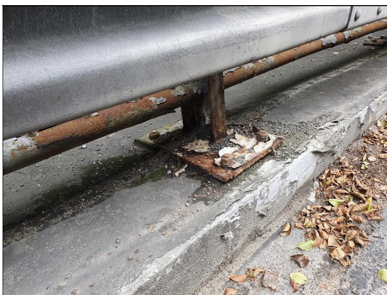
Poškozená patní deska sloupku svodidla
